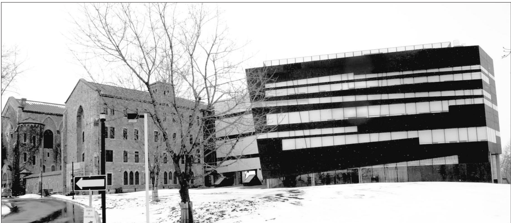
Le nouveau bâtiment en aluminium anodisé noir est relié à l'ancien monastère par une aile aérienne.
