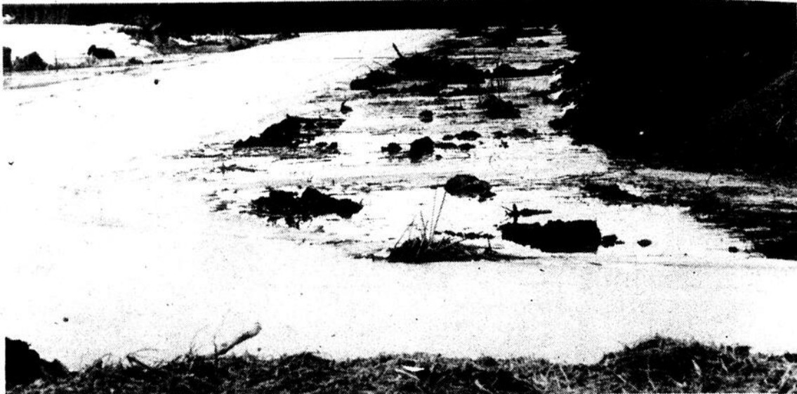
Sur la 31 ème Avenue, l'endigement est terminé.
