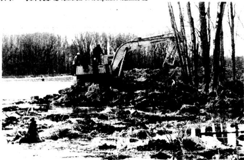
Sur la 7 ème Avenue, le chantier offre un spectacle désolant. Les travaux se font dans des conditions difficiles. La qualité du sol se prête mal à l'excavation. (Photos François Melillo)
