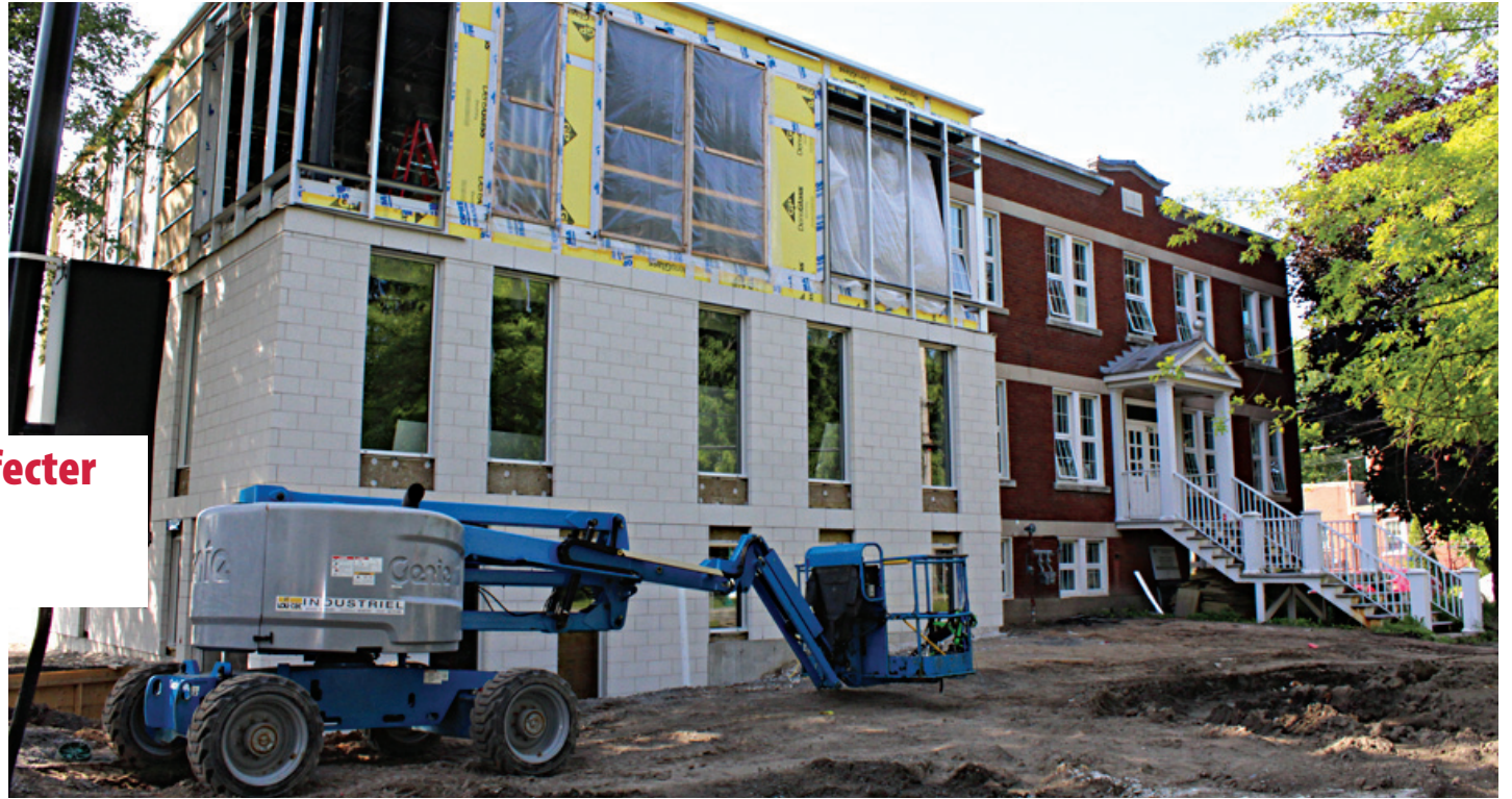
Les travaux d'agrandissement de la mairie, à Saint-Basile-le-Grand, ont duré plus d'un an. (Photo : archives)
