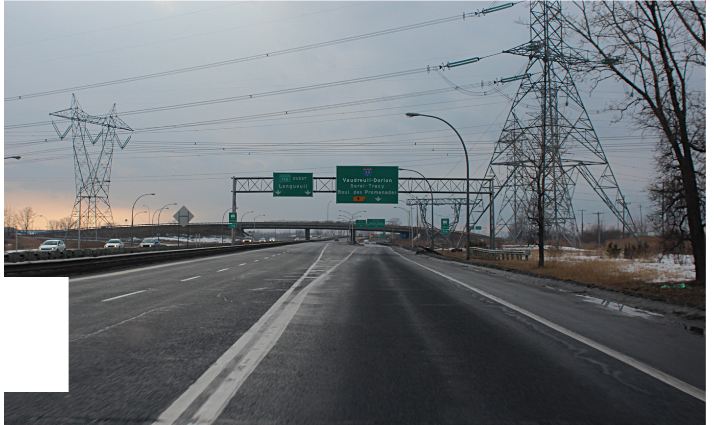
Des travaux importants auront lieu sur l'autoroute 30 Ouest à Saint-Bruno en 2020. (Photo : archives)
