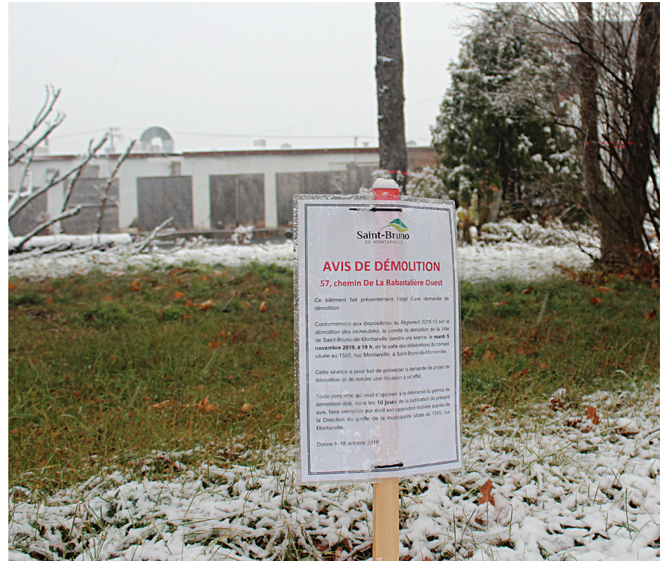
Le comité de démolition a autorisé le 5 novembre dernier que soient rasés les bâtiments du site de l'ancienne usine Natrel. (Photo : archives)
