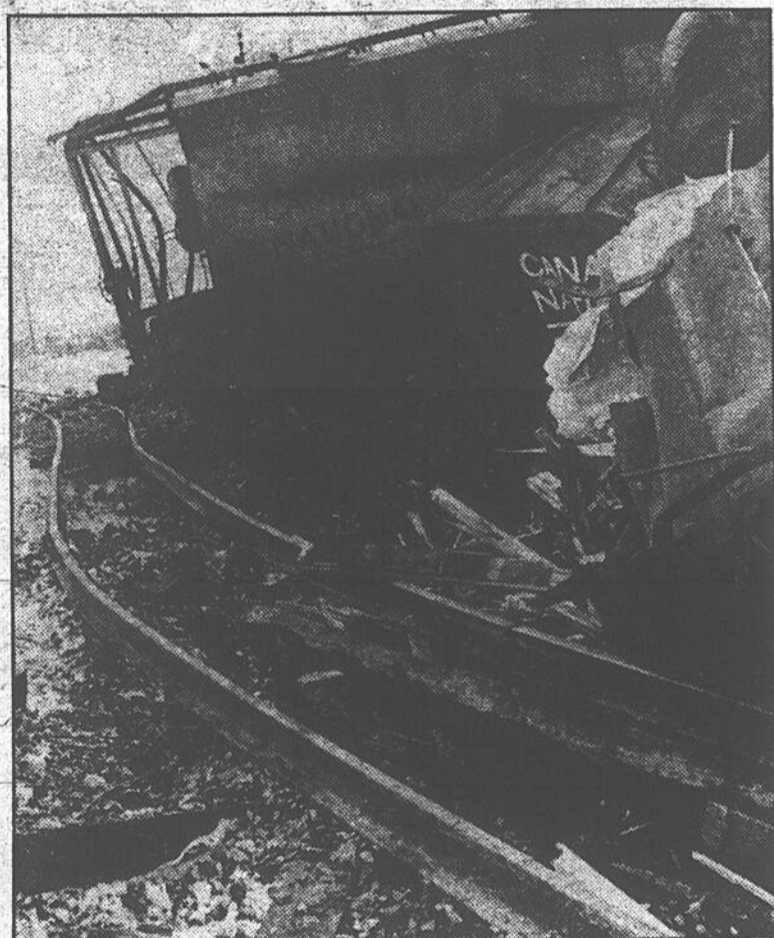
Selon un porte-parole du CN il faudra encore deux jours aux ouvriers pour dégager et réparer la voie.
