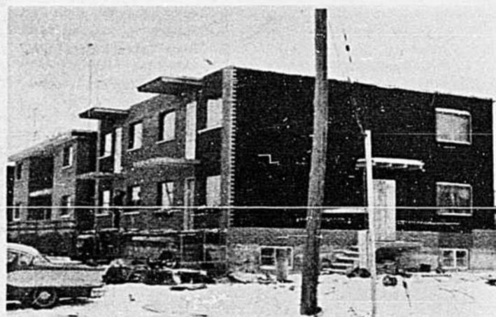
Construction de deux maisons appartements au Village Lafontaine.
