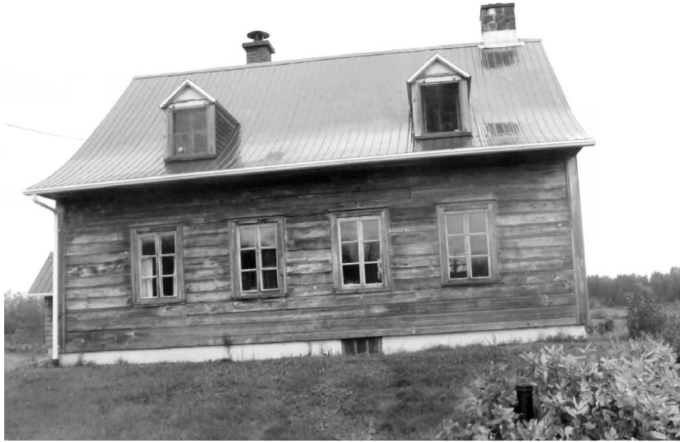
Maison dite des Lemieux, numéro 2, chemin des Roy
