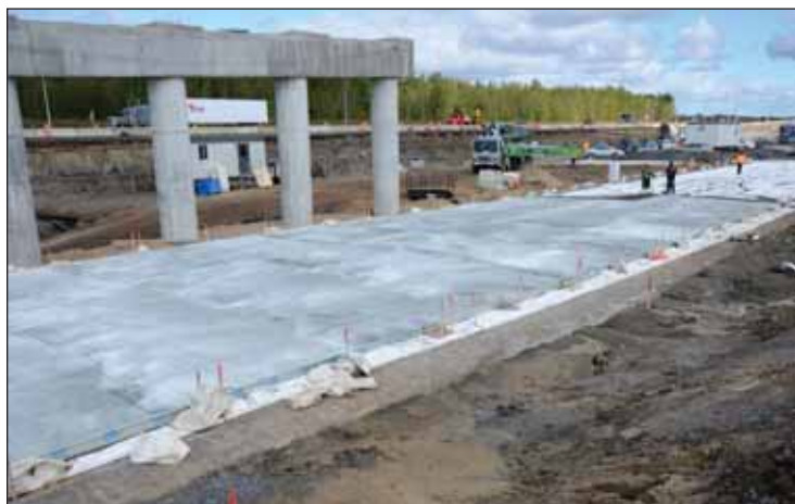
Figure n° 3 - Aperçu de la chaussée en déblai sous un ouvrage en construction.
