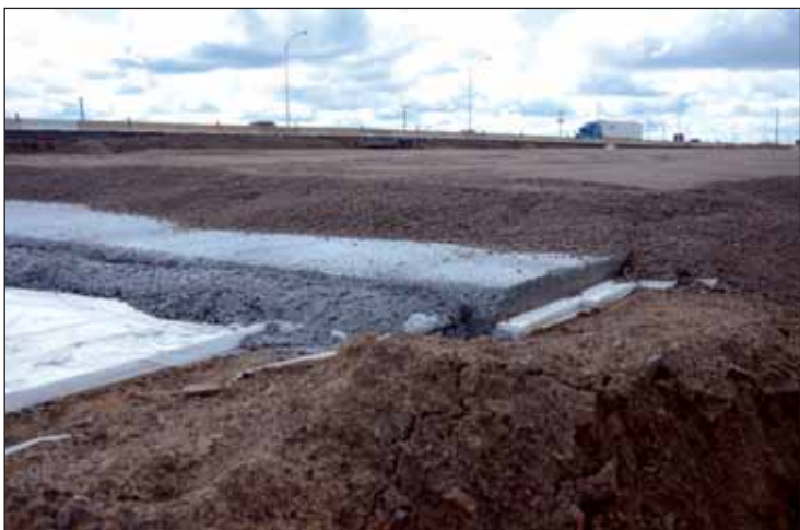
Figure n° 4 - Les couches de la structure de chaussée en déblai.
