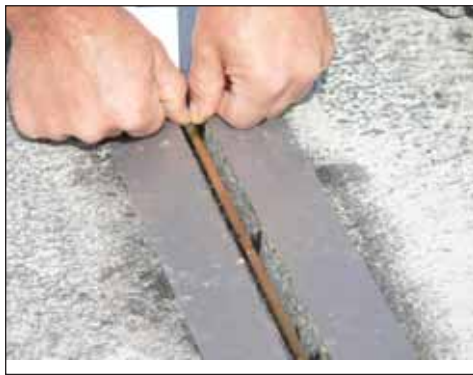
Figure 1 : Pose d'un capteur piézoélectrique
