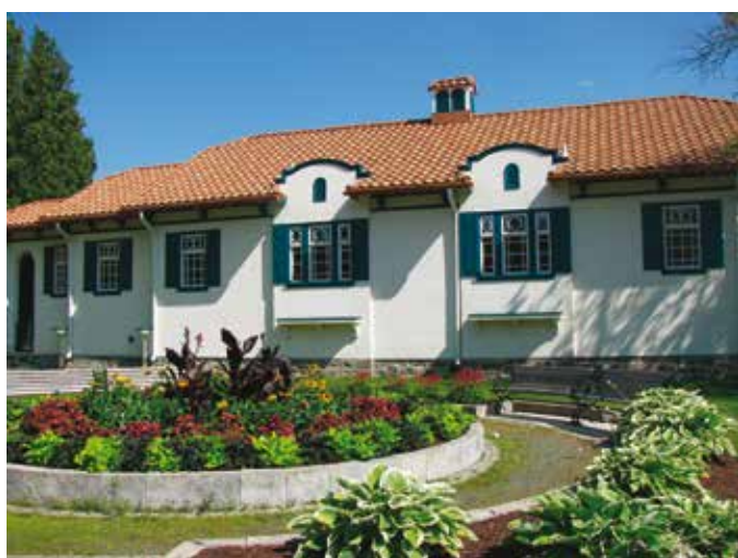
Inspiré des pavillons espagnols et dessiné par Jules Caron, le pavillon de services de la piscine du parc Saint-Maurice a été entièrement restauré en 2013.
