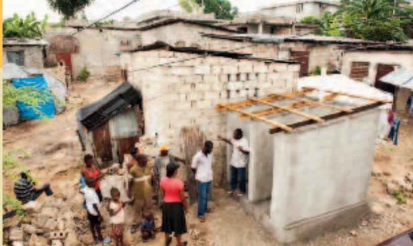
Construction de latrines. Photo © Éric St-Pierre/Oxfam Québec
