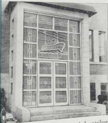
Le lustre riche et discret du métal contribue à la beauté de l'ensemble architectural, comme en témoigne l'édifice de la Cie Albert G. Baker Limited à Québec.
