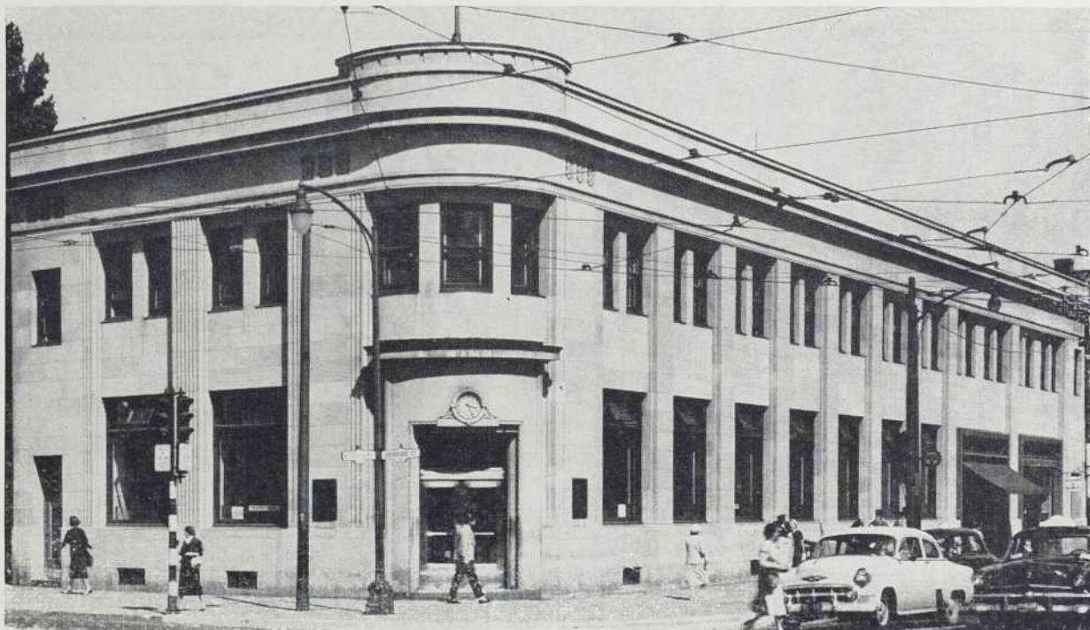
EDIFICE DE LA BANQUE D'ÉPARGNE — ANGLE VICTORIA & SHERBROOKE, WESTMOUNT, P.Q.
