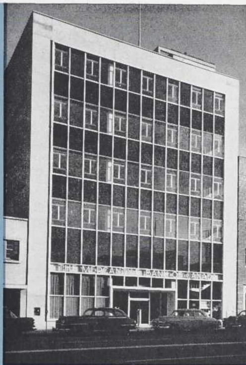
La Banque Mercantile du Canada, Vancouver Architectes: McCarter, Nairne & Partners, Vancouver
