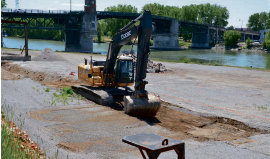
Le chantier s'est mis en branle le lundi 15 juin. Photo Katy Desrosiers | Les 2 Rives ©
