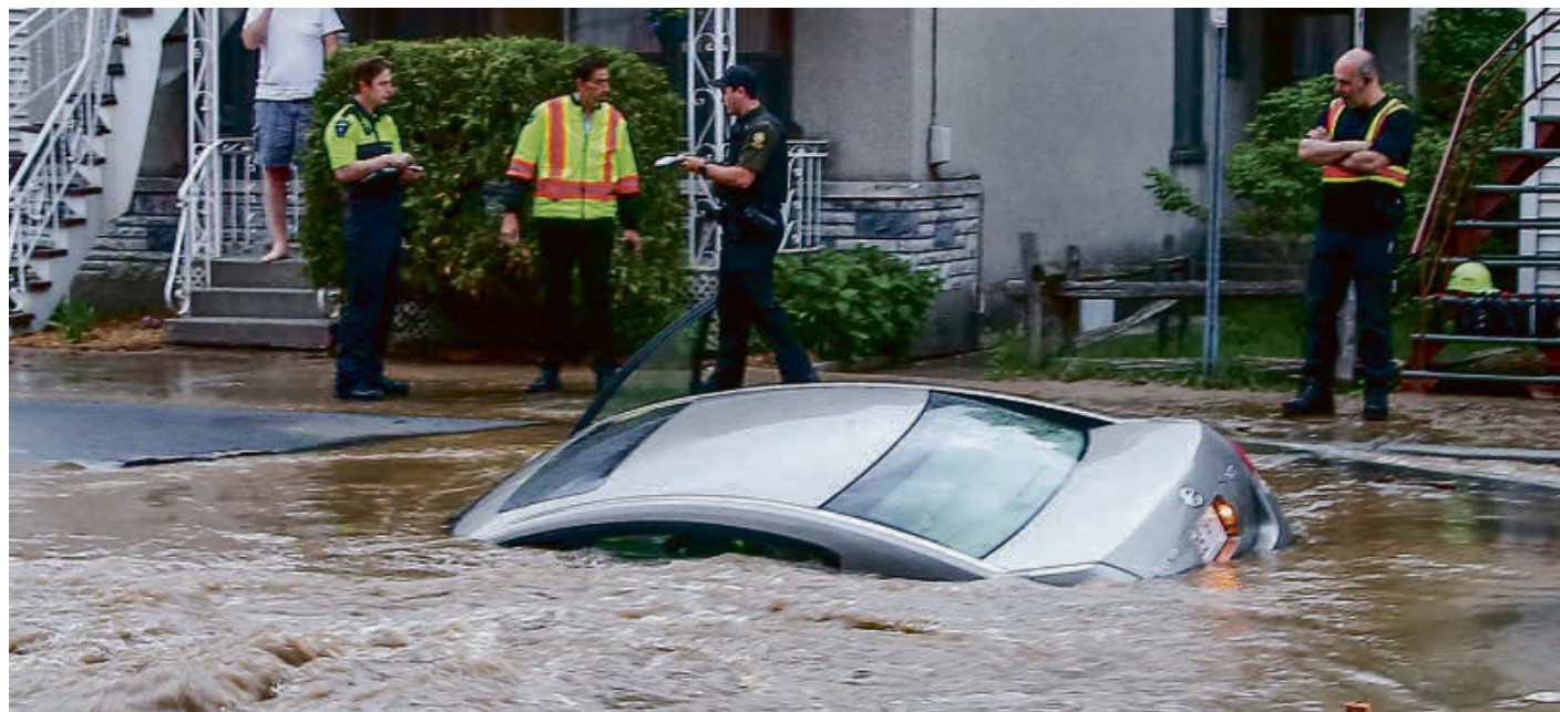
Le trou béant sur le boulevard Fiset a été causé par le bris d'un joint de conduite d'aqueduc résultant des vibrations d'un rouleau-compresseur d'asphalte, selon les premières observations. Photo Pascal Cournoyer | Les 2 Rives ©
