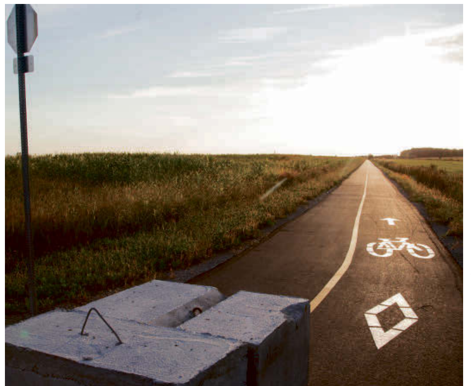
Une reconstruction de deux ponceaux est nécessaire pour le prolongement de la piste cyclable La Sauvagine vers Yamaska. Photo Pascal Cournoyer | Les 2 Rives ©
