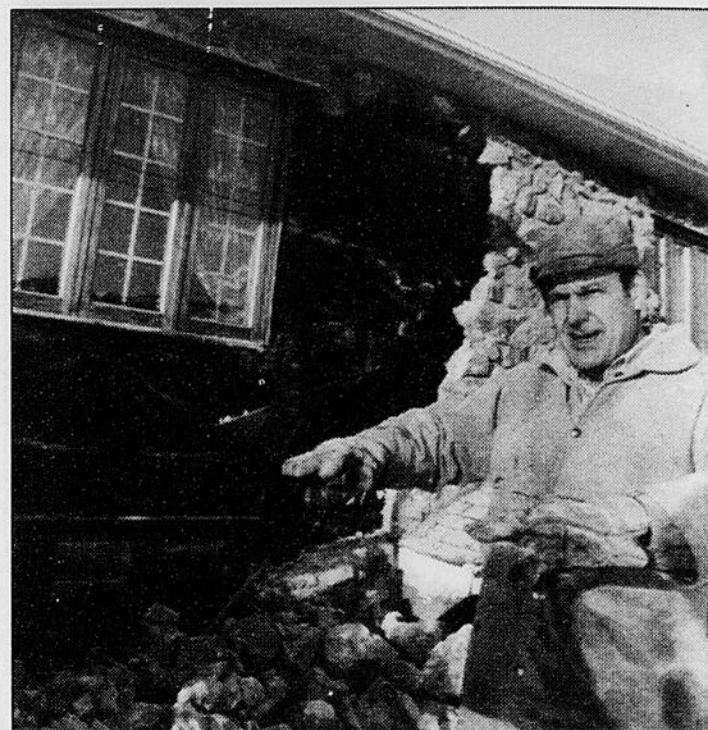
DOMMAGES - La secousse sismique du 25 novembre 1988 a causé d'importants dommages à cette résidence de Ville de La Baie. Le propriétaire, Robert Jobin constate les dégâts.
