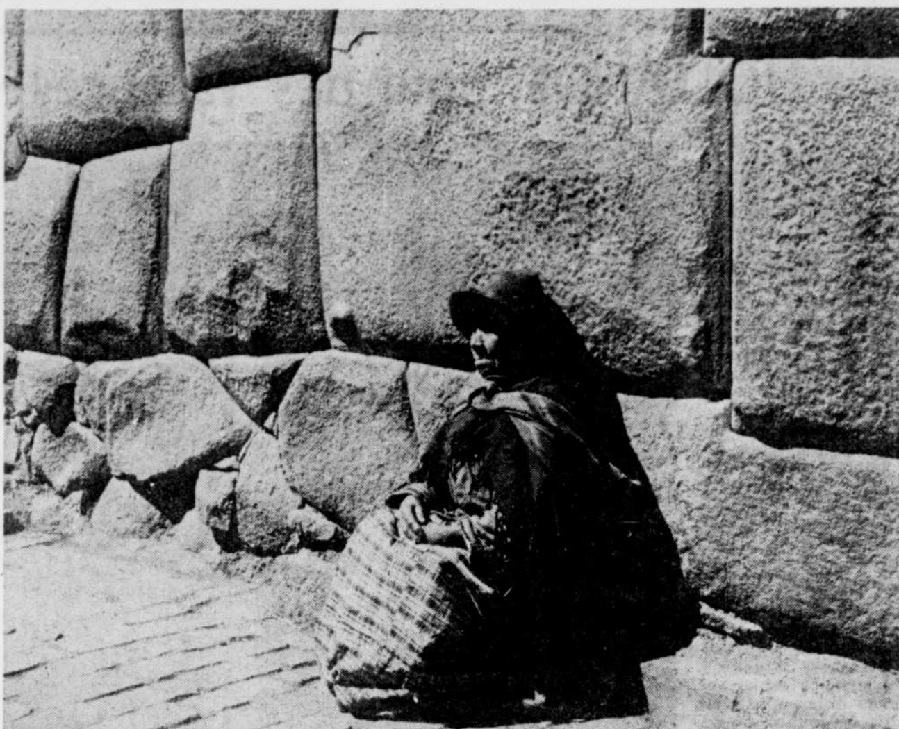
Ces blocs énormes, joints sans ciment, ont défié les tremblements de terre et l'usure du temps, après la ruine de Cuzco.
