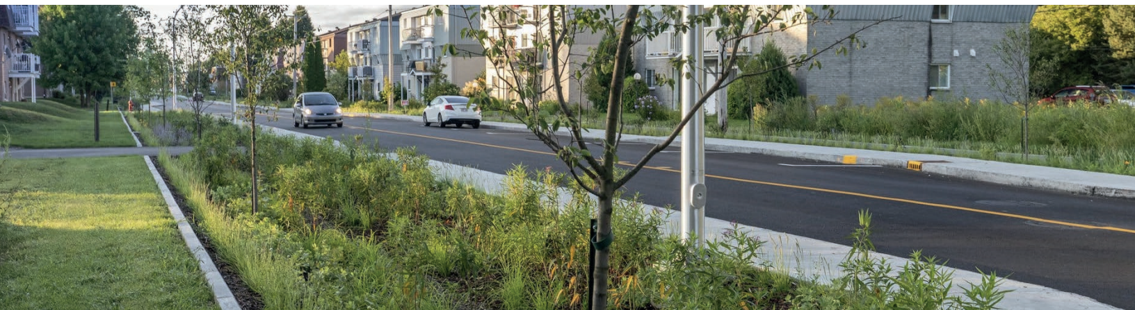
Rue Saint-Maurice, une fois le réaménagement complété. Crédit : Ville de Trois-Rivières
