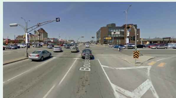
Boulevard Le Corbusier, avant le réaménagement. Crédit : Google Streets View
