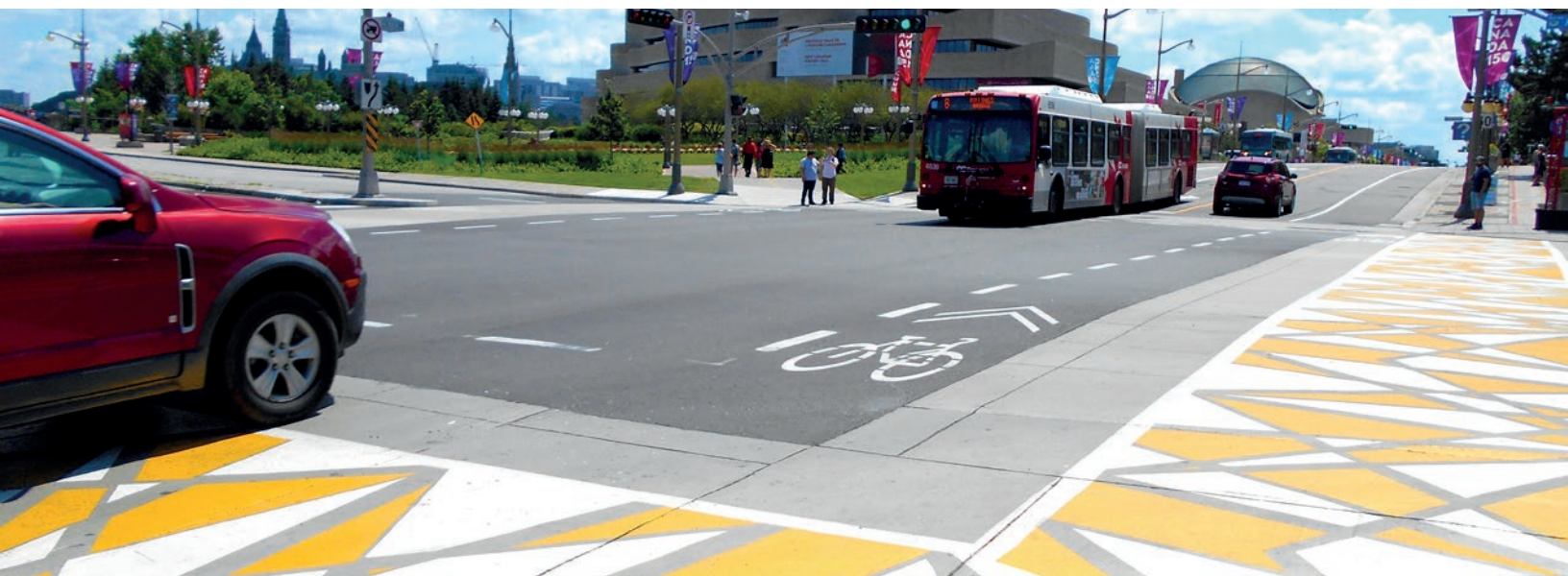
Rue Laurier, une fois le réaménagement complété. Crédit : Ville de Gatineau
