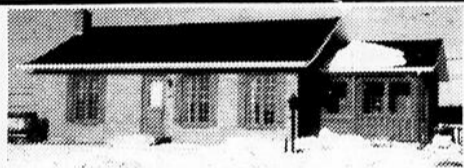
Sacré-Coeur, 720 rue Des Sources. Très joli bungalow genre chaumière, sous-sol partiellement fini, foyer, une sortie pour l'extérieur. Vue sur le fleuve.
