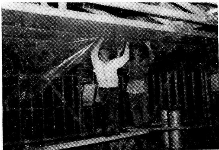
Pose du polyéthylène au plafond
