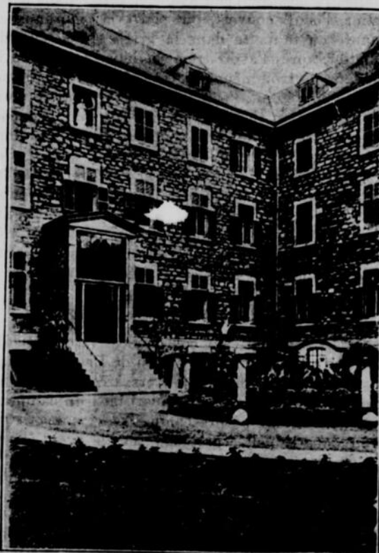
L'entrée de la Réforme, rue de Montigny
