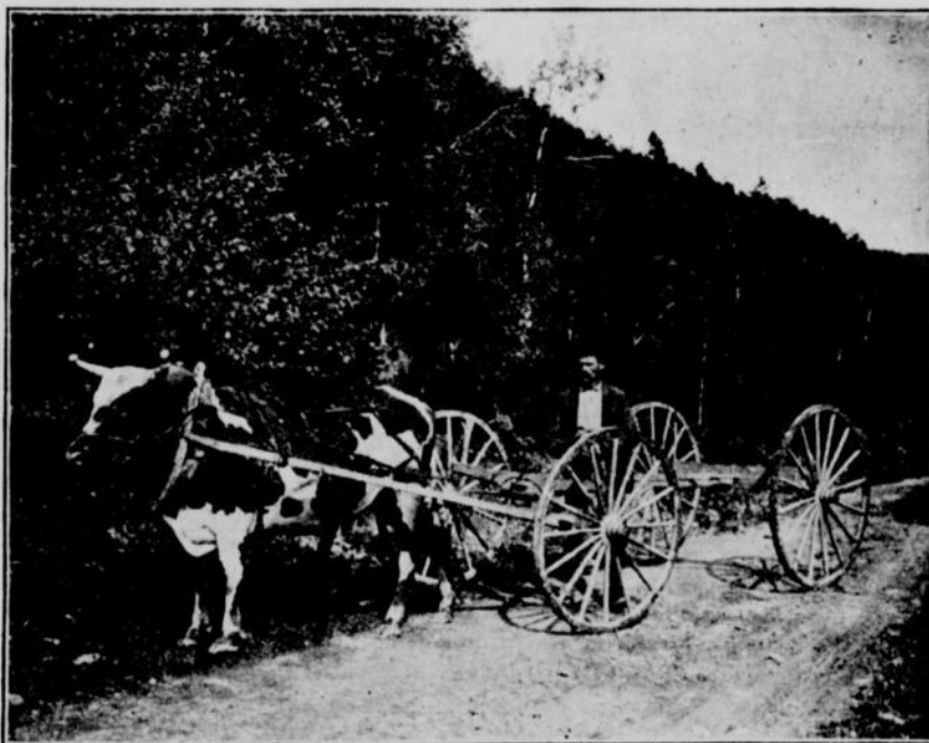
"Automobile" original en usage dans la vallée de la Métapédia
