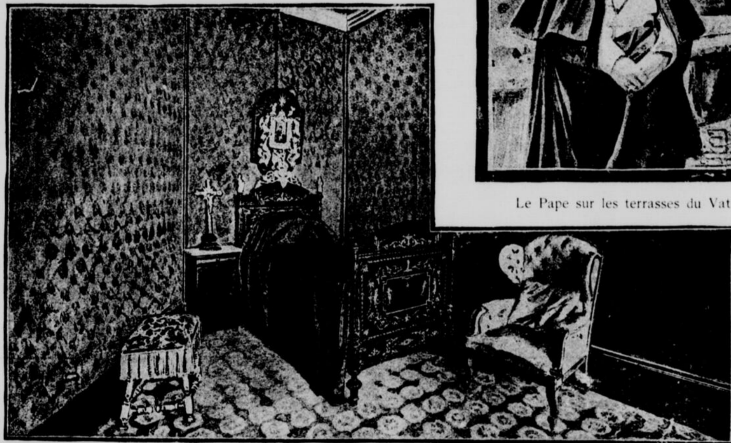
La chambre à coucher, dans la Tour Léonine
