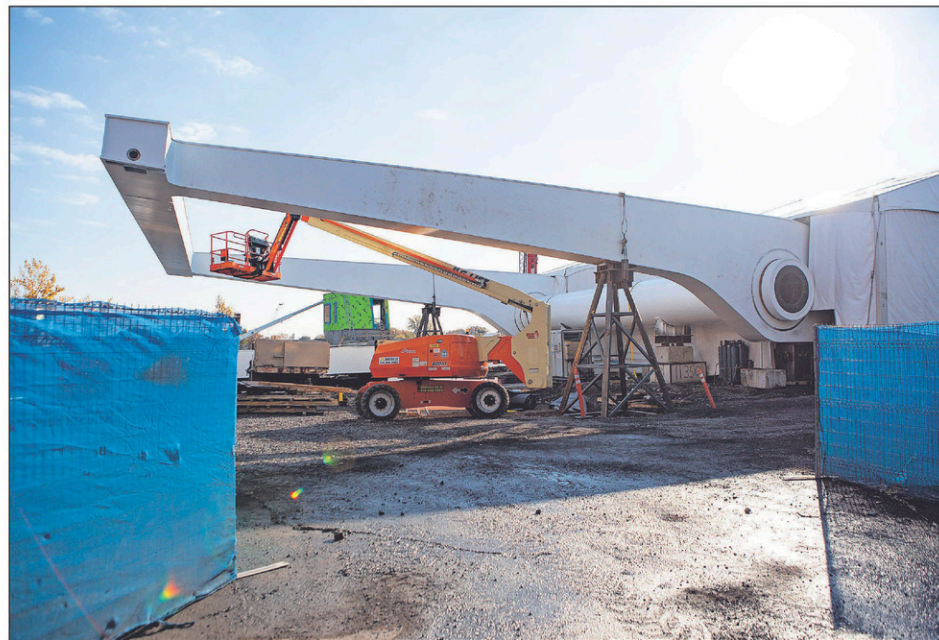
L'assemblage du pont-levis progresse. La structure sera pour le moins monumentale.
