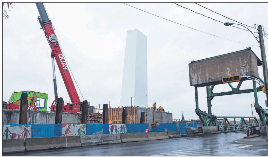
Un morceau du pilier supportant le pont-levis a été mis en place cette semaine. Il sera prolongé d'un mât s'élevant à une hauteur de dix étages.
