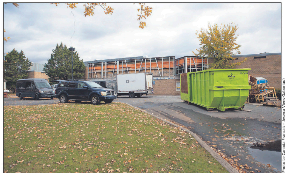
Après l'agrandissement, les travaux se poursuivent avec le réaménagement de l'édifice qui a été construit en 1984.
