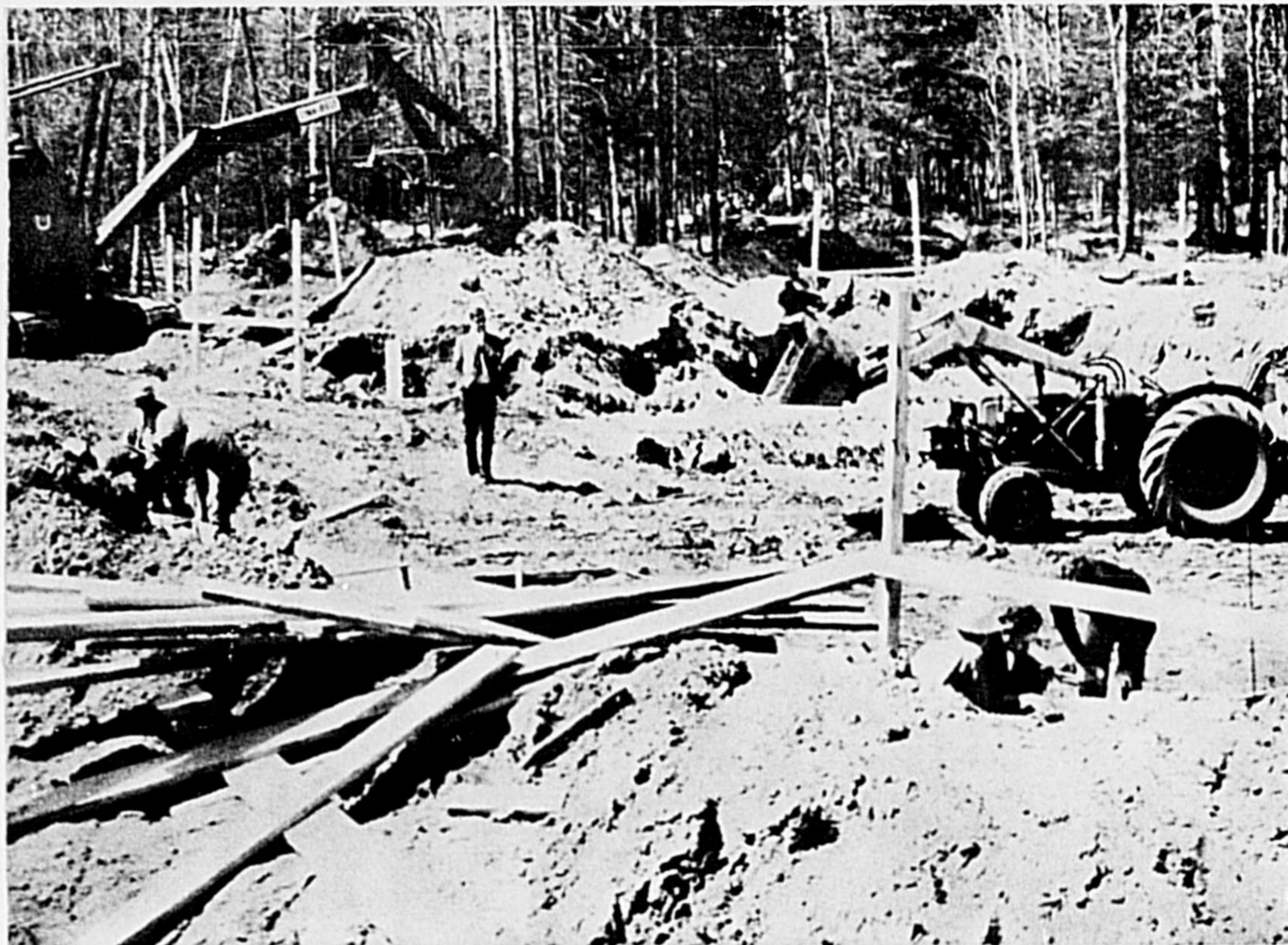
PISCINE. — Cette photographie fait voir où en étaient rendus la semaine dernière les travaux de construction de la future piscine du nouveau parc de loisirs du secteur Mgr Grenier. Au train
