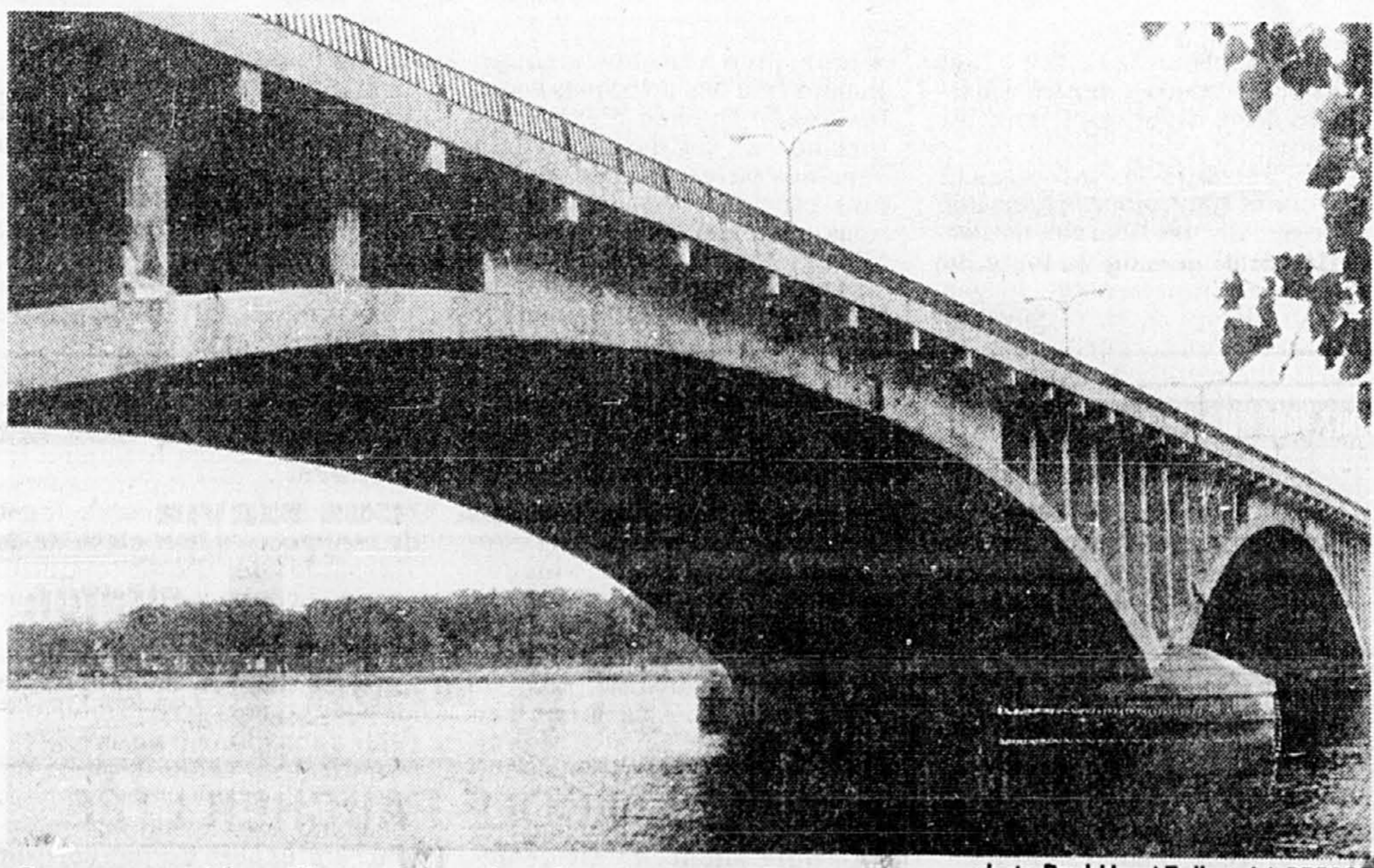
On a conservé les piliers et les arches d'un «pont vieilli».
