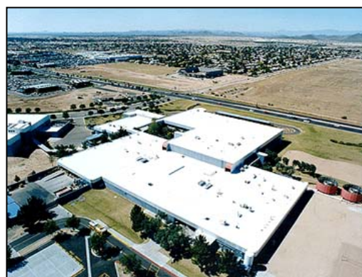
d) Utilisation d'une couleur réfléchissante (albédo aux alentours de 0,9) (Source : http://www.arizonafoam.com )
