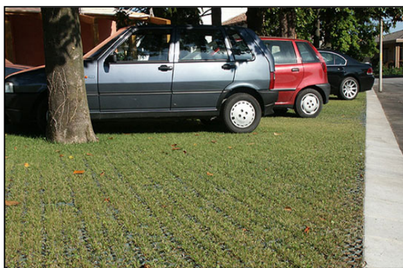
c) Utilisation d'un pavé perméable (Source : http://www.inhabitat.com )
