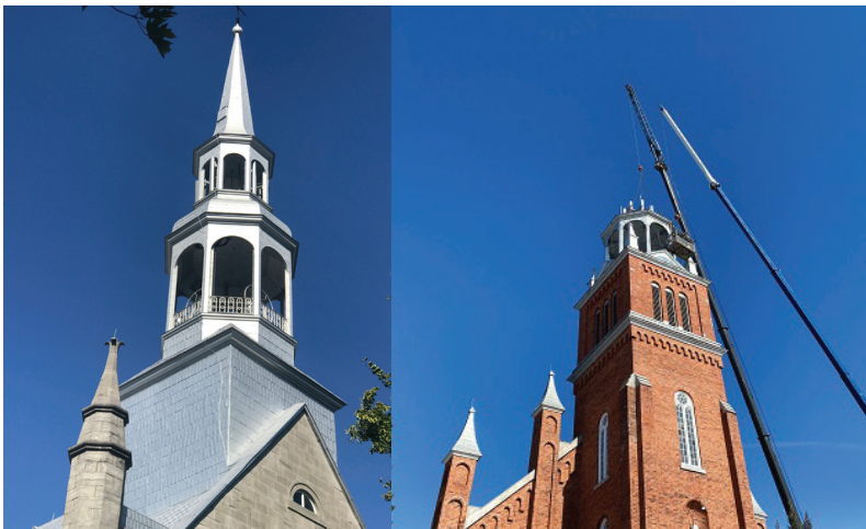
La dépose du clocher, en mars 2021 Photo : Yvon Bruneau
