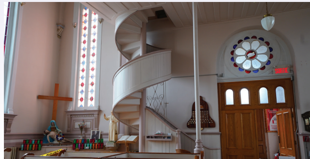
Escalier en colimaçon de l'église Saint-Roch-de-Richelieu. Ce type d'escalier est une « signature » de Victor Bourgeau qui, comme menuisier, s'était fait connaître par de tels ouvrages
