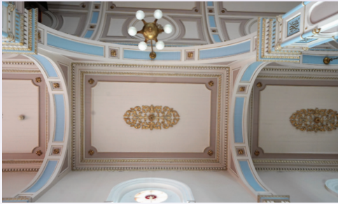
Plafonds des bas-côtés de l'église Saint-Roch-de-Richelieu
