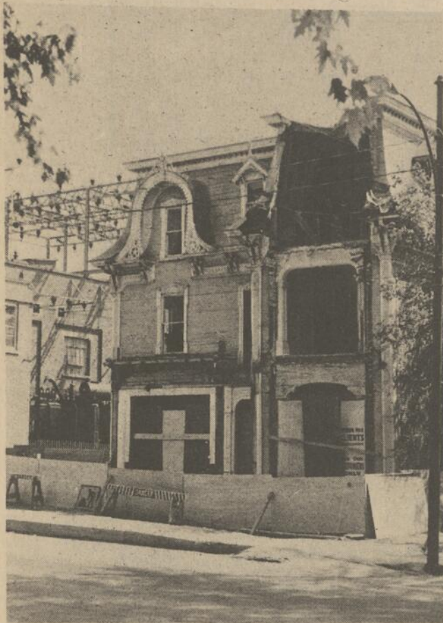
Les ouvriers de la construction sont toujours en grève à Granby et la région, comme dans la majorité de la province et tout est silencieux sur les différents chantiers.
