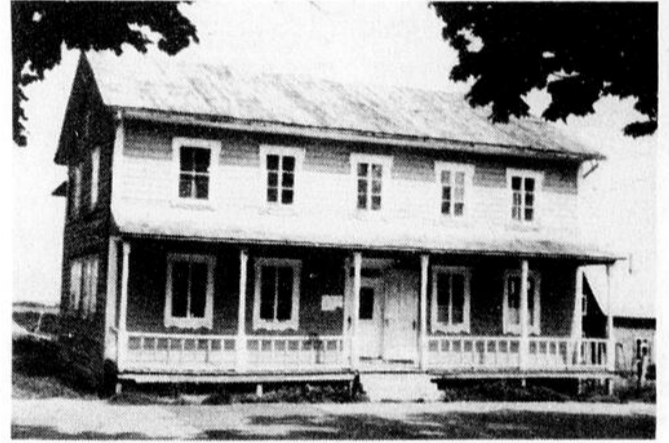
Cette bâtisse, dont la construction remonte à 1905 et qui a servi de couvent avant d'être convertie en salle municipale, tombera sous le pic des démolisseurs d'ici les prochaines semaines. Elle fera place à un hôtel de ville moderne, construit au coût de quelque $168,000, moyennant une subvention du ministère des Affaires municipales de l'ordre de $60,000. Entretemps, pour les quatre ou cinq mois de la durée des travaux, le Conseil municipal sera appelé à siéger dans l'une ou l'autre des deux écoles de St-Eugène, suite à une entente avec la Commission scolaire Trois-Saumons.
