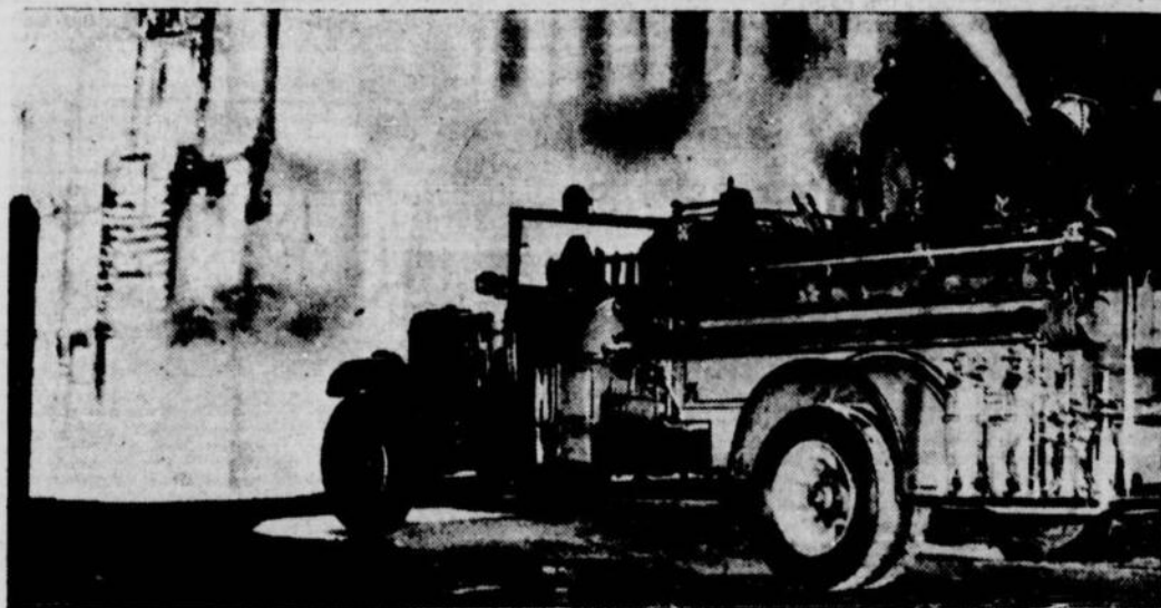
Photo saisissante de l'incendie qui a ravagé une usine à Pawtucket, (Rhode-Island) causant plusieurs milliers de dollars de dégâts.
