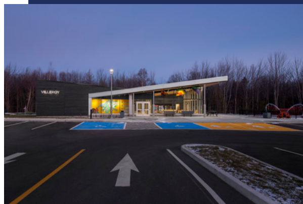
Halte routière modernisée à Villeroy (autoroute 20, en direction ouest)
