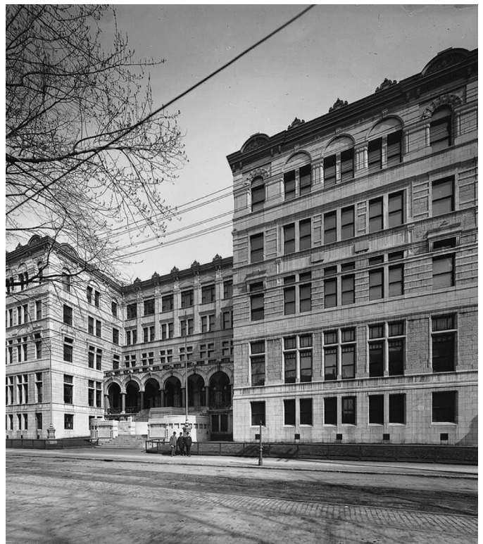
Université Laval à Montréal (1903). L'Institut botanique logeait au rez-de-chaussée du vieil immeuble de la rue Saint-Denis. Les équipements, les herbiers étaient à la merci des dégâts d'eau et des rongeurs. Édifice occupé jusqu'en 1942 par l'Université de Montréal. Notman. Collection McCord Stewart.
