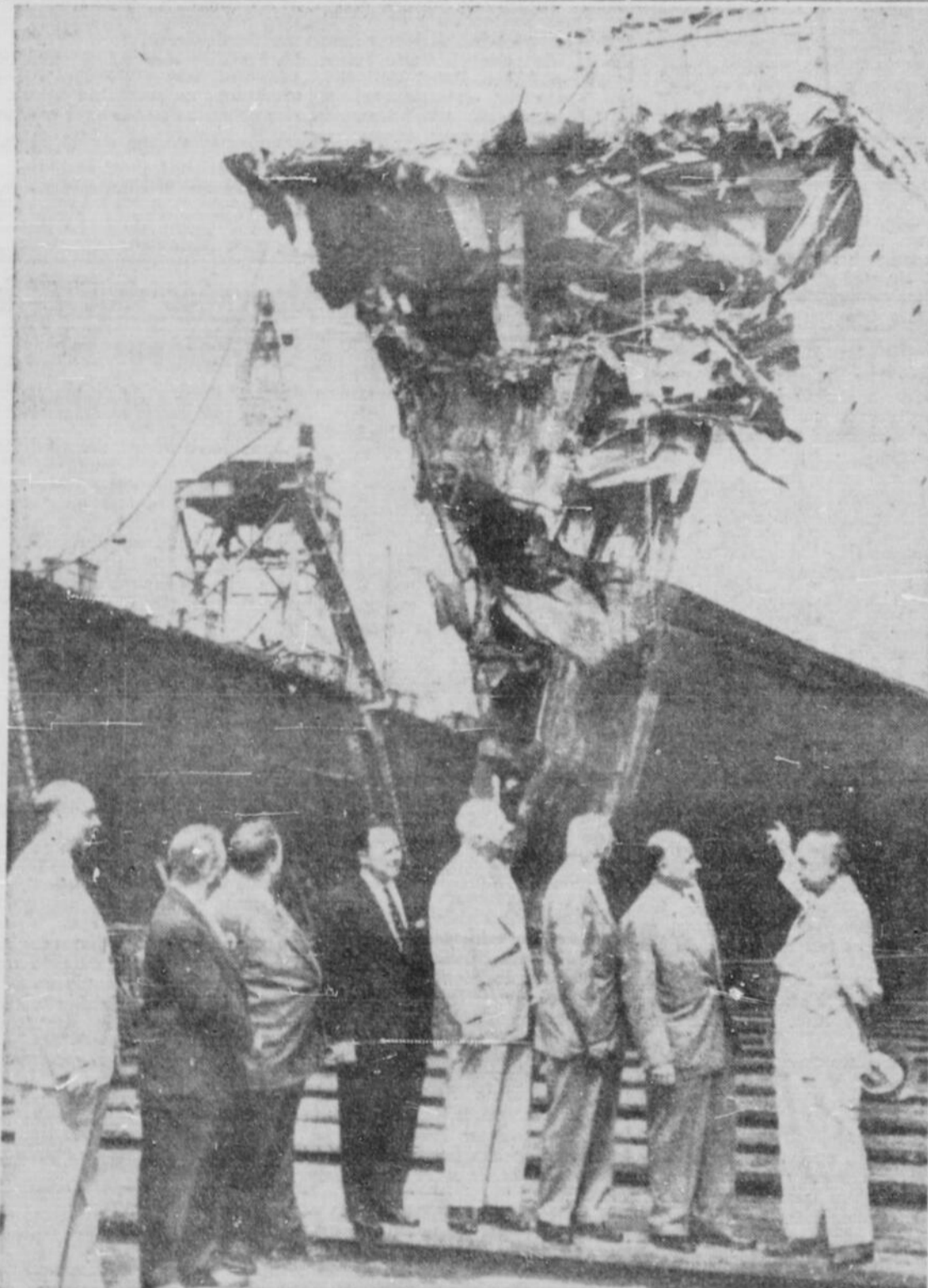
DEVANT LA BLESSURE — Des membres du sous-comité de la marine marchande du Congrès américain examinent dans une cale-sèche de New-York les avaries causées à la proue du navire suédois "Stockholm" au cours de sa collision avec le paquebot italien "Andrea Doria", afin d'étudier, si des instruments de sécurité plus à point auraient pu prévenir le désastre. Ce sont de g. à d. MM. Edward-A. Garmatz, du Maryland; James A. Byrne, de Pennsylvanie; T. James Tiplaty, du New-Jersey; Irwin-D. Davidson, de New-York; John-J. Allen, de Californie; John-J. Ray, de New-York; Francis-E. Dorn, de New-York; et Robert C. Bonner, de Caroline du Nord, président du comité.
