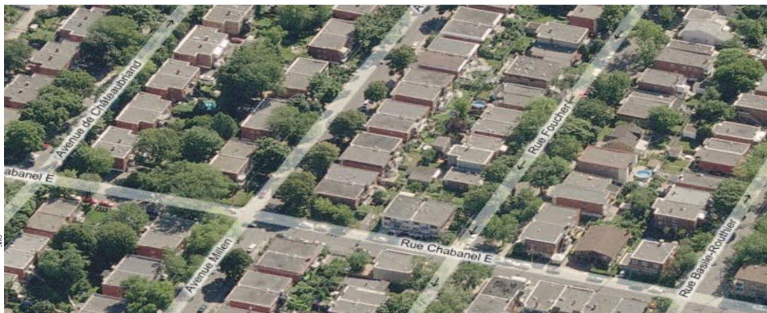
Habitations des années 1950 dans le quartier Ahuntsic, à Montréal.
