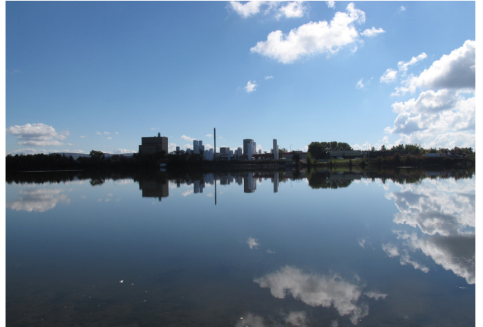
USINE DE FILTRATION DES EAUX ET ACTIVITÉS INDUSTRIELLES EN MARGE DU RÉSERVOIR BEAUDET
