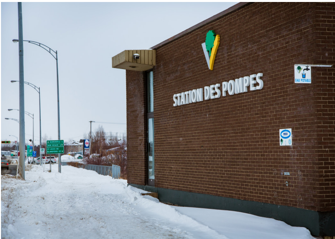
STATION DES POMPES EN FACE DE L'USINE D'EAU POTABLE HAMEL
