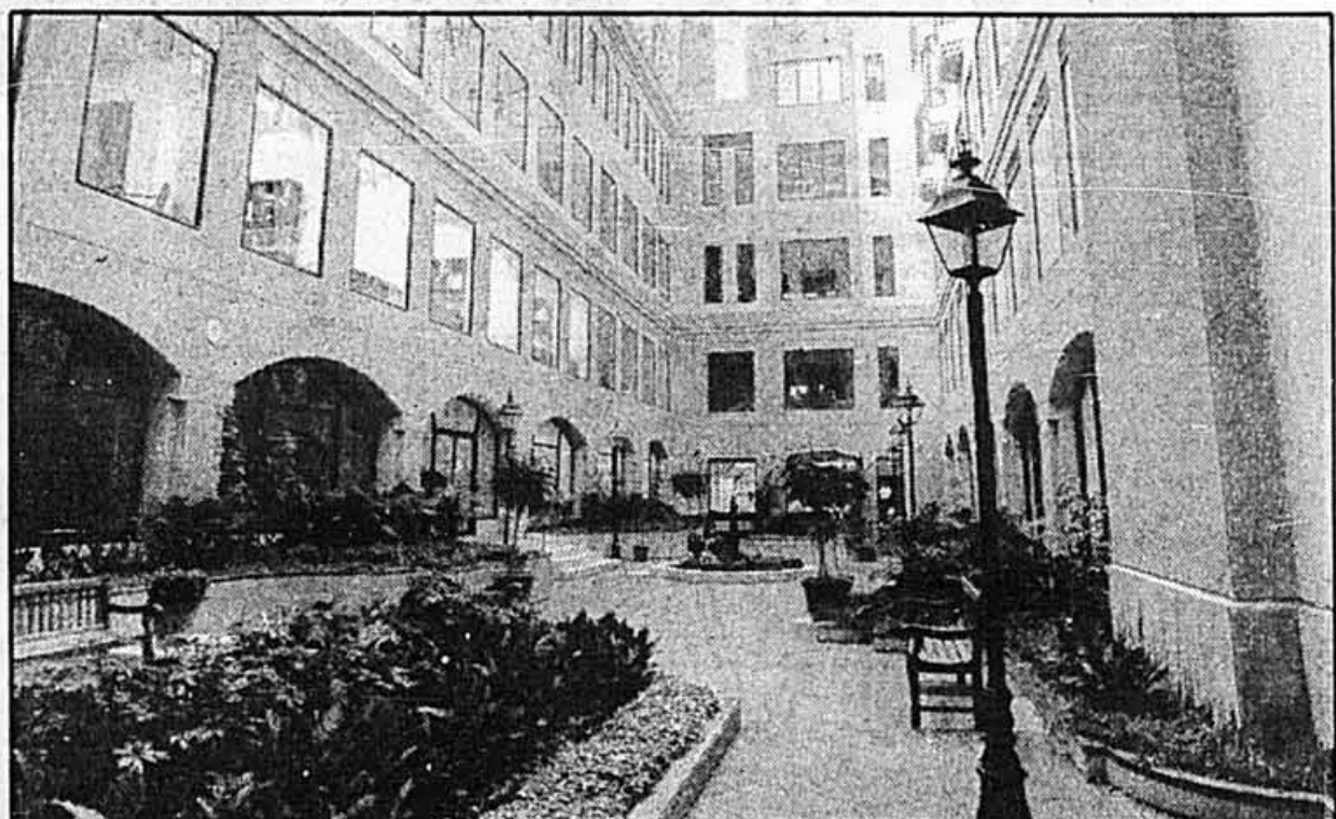
L'architecte Ray Affleck a choisi de créer cet atrium, ce jardin, dans la cour intérieure du Windsor recyclé.
