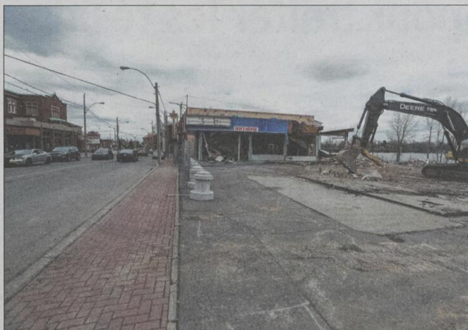
La Ville a démolé les bâtiments pour utiliser le terrain comme stationnement, estimant qu'il ne s'agit pas d'un changement d'usage.
