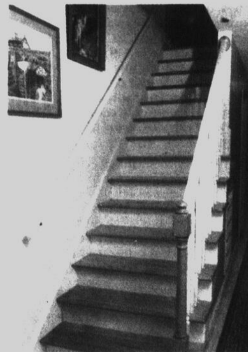
Les escaliers et les marches doivent être bien éclairés et dotés d'une main courante solide.
