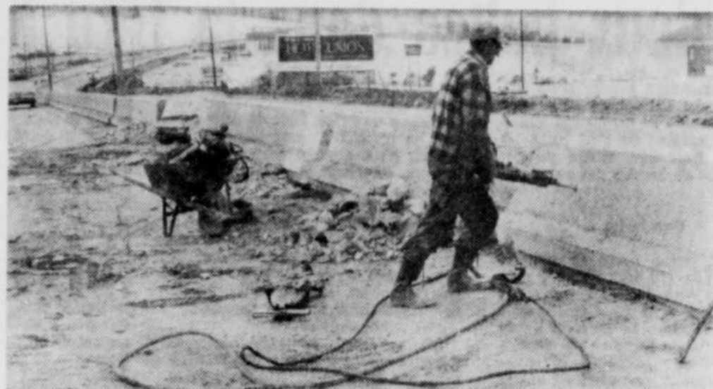
Les travaux sont en cours boulevard Bourque en vue de la construction de l'échangeur. Pour la réalisation de ce projet, une partie de la bande médiane devra être enlevée. (Photo La Tribune, par Guy Cardinal)
