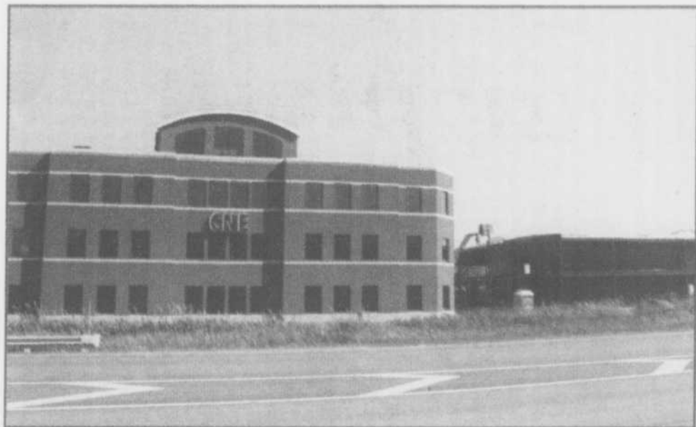
Le groupe Amireault-Peetrons investit à Lachenaie. Ici, l'édifice CNE et le deuxième immeuble de 28 000 pieds carrés, en construction.
