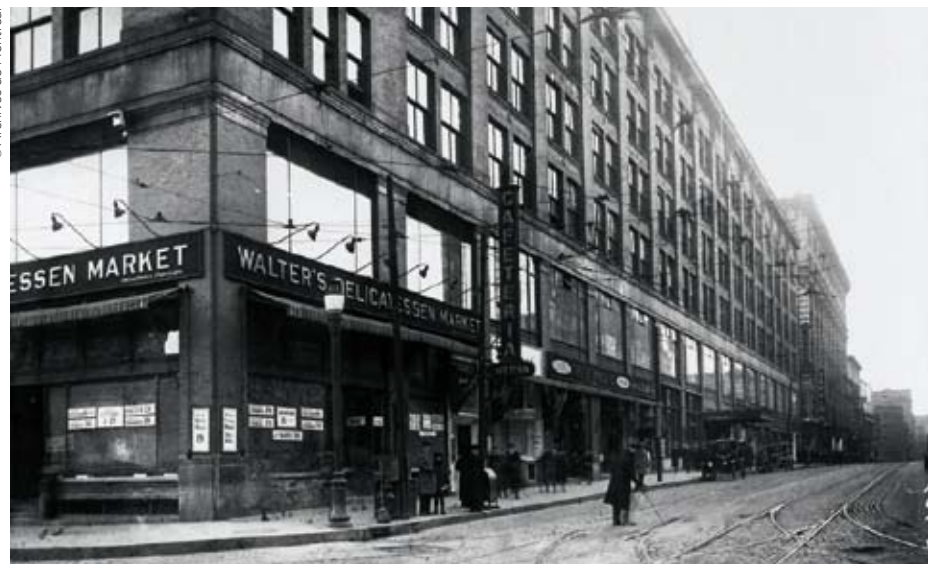
Vue de la rue Sainte-Catherine Ouest, à l'angle de la rue De Bleury
