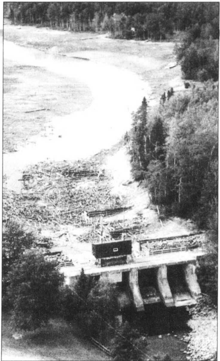
BARRAGE - Cette photo aérienne fait voir ici l'état des lieux aux abords du barrage de Stone-Consolidated quelques jours après que le lac Ha! Ha! se soit vidé de ses eaux.
