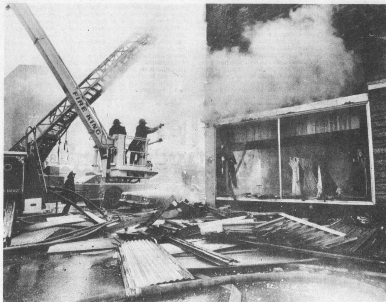
Un violent incendie, qui a nécessité quatre alertes, a complètement ravagé une bijouterie sise au 1119 est, rue Sainte-Catherine, à l'intersection de Wolfe, en plus de causer des dommages considérables à trois autres commerces, dont un graveur et une lingerie, hier après-midi. Les pompiers, qui ont mis au-delà de deux heures à maîtriser l'incendie, ont découvert des trous sur le toit ainsi que de la marchandise entassée à l'arrière du commerce. Une enquête a été instituée. (Photo Réjean Meloche)
