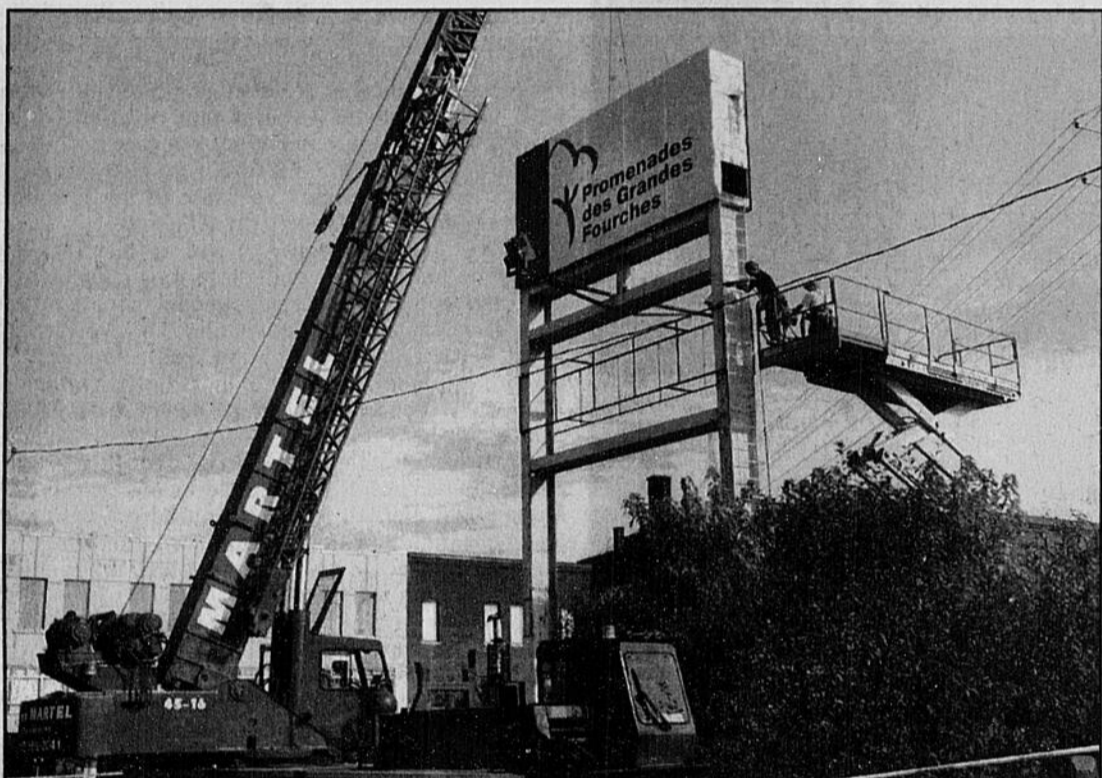
Imacom, Jocelyn Riendeau Plus de deux ans après la démolition du bâtiment des Promenades des Grandes-Fourches, pour faire place à un supermarché Maxi, la chaîne Provigo-Loblaw a complété le démantèlement de l'affiche du défunt centre commercial. Le geste est accueilli avec soulagement par les promoteurs du centre-ville qui s'efforcent de chasser les images d'un quartier moribond.
