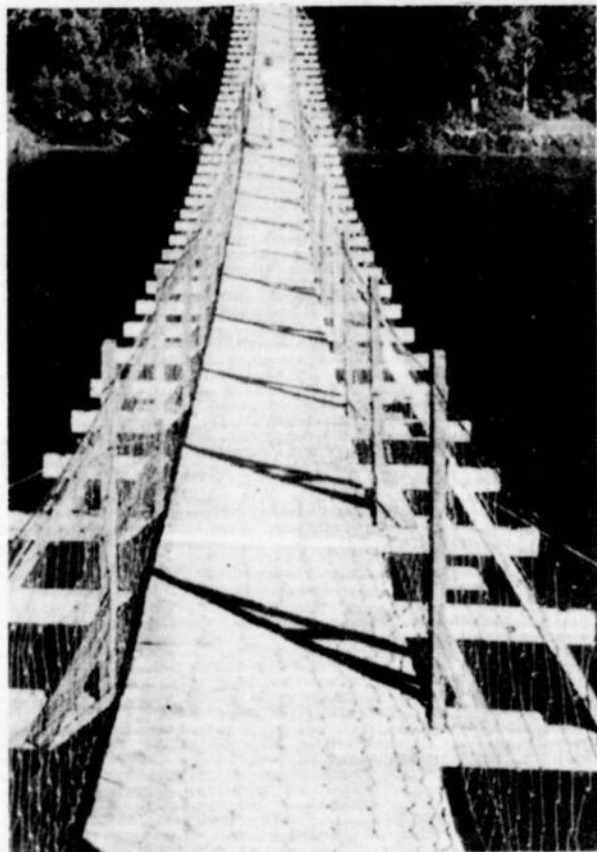
Long de 582 pieds, ce pont de bois tournant construit vers le début du 20e siècle enjambe la rivière Souris, dans le sud du Manitoba. D'une seule travée, l'ouvrage a très bien résisté aux intempéries comme aux ravages des années, comme en fait foi cette photo émanant du Tourisme manitobain à Winnipeg.
