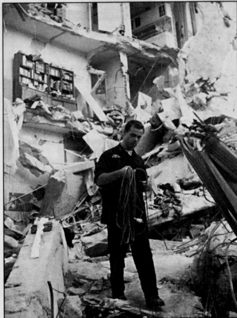
Un édifice lourdement endommagé tient encore debout malgré tout après le séisme d'une magnitude de 5,9 Richter qui a fait environ 16 000 sans abris. photos Associated Press
