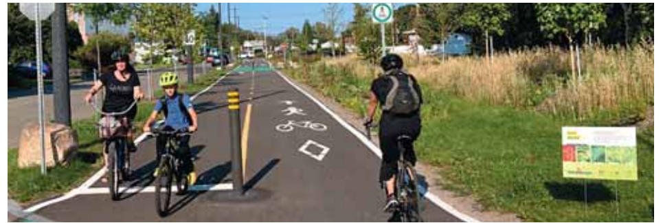
Toutes les intersections sont sécurisées avec les rues perpendiculaires par de la signalisation et du marquage vert sur la chaussée. (Photo : Michel Bédard)
