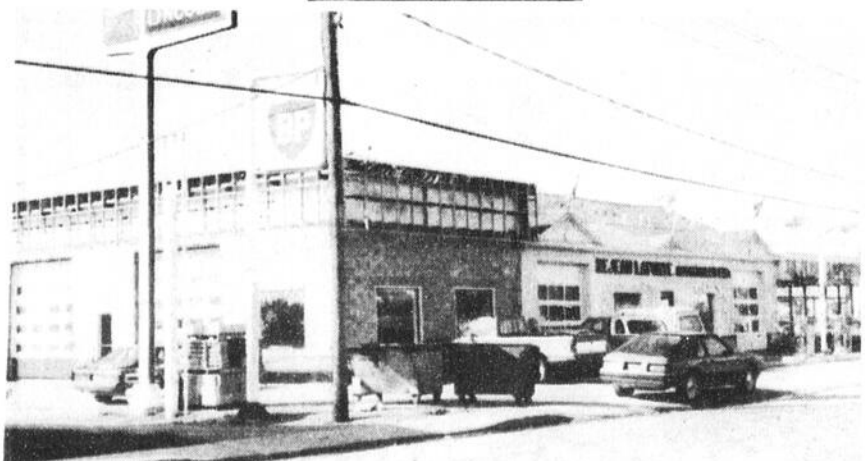
Le garage Laporte, à Saint-Norbert. Des travaux d'agrandissement sont présentement en cours. Une fois complétés, ces travaux évalués à environ $ 150,000, créeront trois emplois. Le garage Laporte s'agrandit d'environ 3,500 pieds carrés grâce aux présents travaux.
