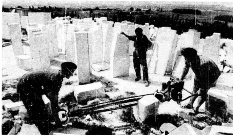
Des carriers débitent les pierres de taille qui servent à la construction de la façade.
