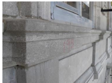
Linteau et corniche
