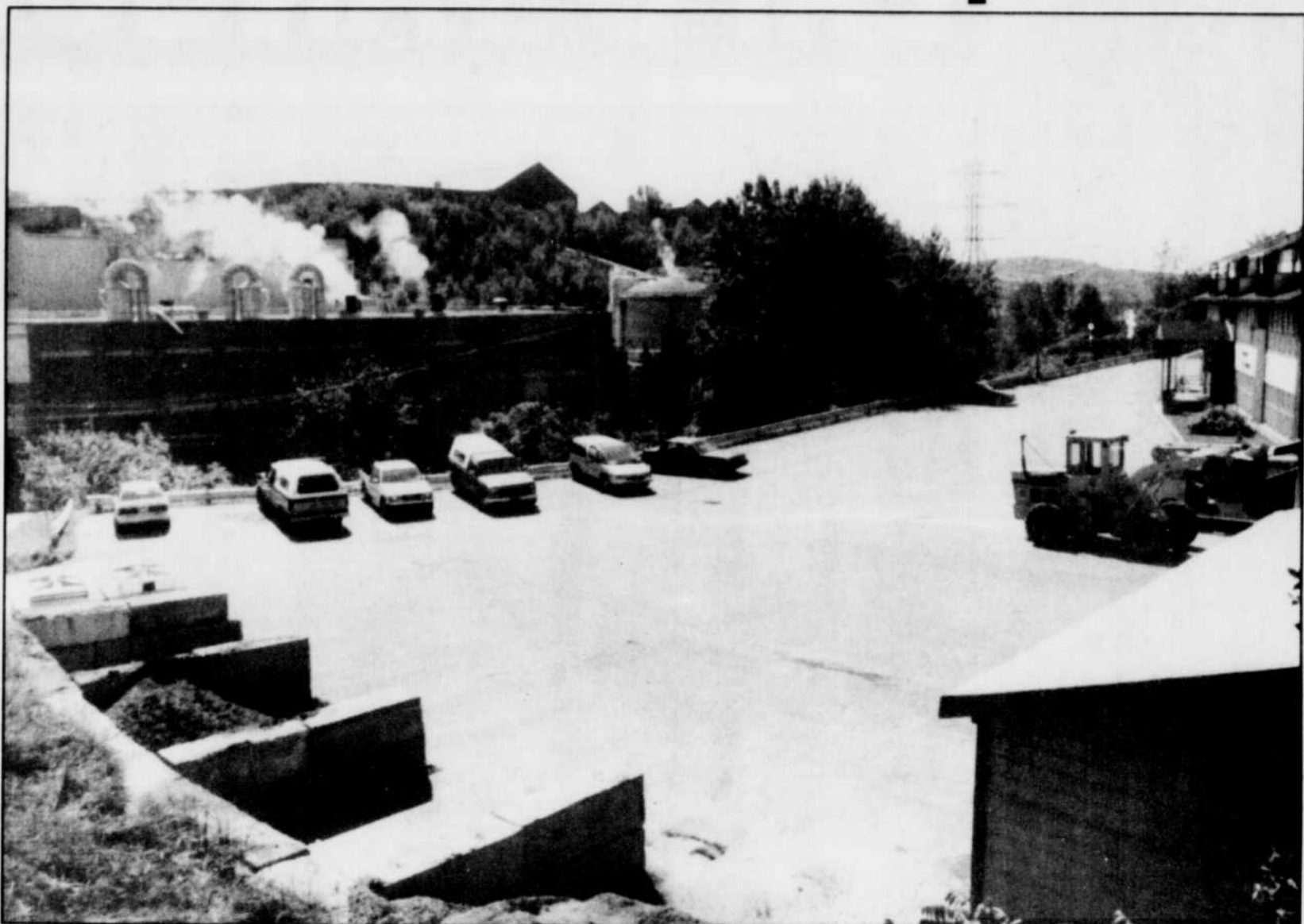
Si la Corporation Stone-Consolidated donne suite à son projet d'agrandissement de l'usine Belgo (en haut, à gauche), comme il y a tout lieu de le croire, le garage municipal et l'hôtel de ville (à droite)
