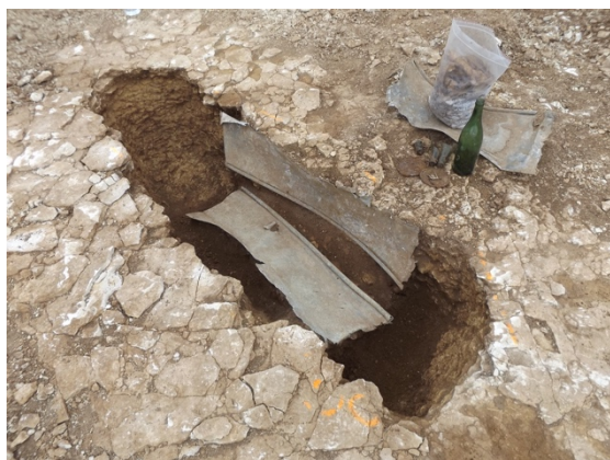
Figure n° 9 : Abri consolidé canadien de Fleury-sur-Orne, avec deux longs fragments de tôle de zinc provenant d'un avion écrasé, réemployés comme éléments de couverture (B. Labbey, Inrap)
