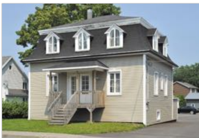
347, rue Commerciale Photo : 150816_5309 Denis Béchard
