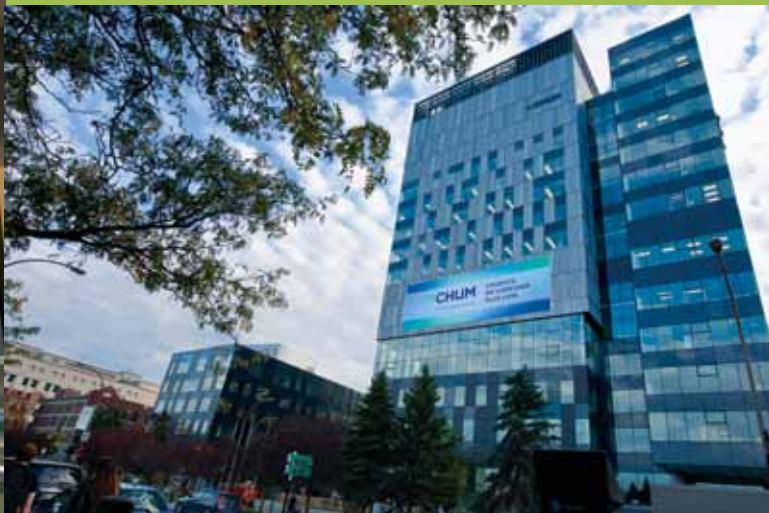
Centre de recherche du CHUM, NFOE associés architectes / Menkès Shoener Dagenais LeTourneux architectes / Jodoin Lamarre Pratte architectes / Lemay et associés / Parkin Architects Ltd Photos: Dominique Lalonde
