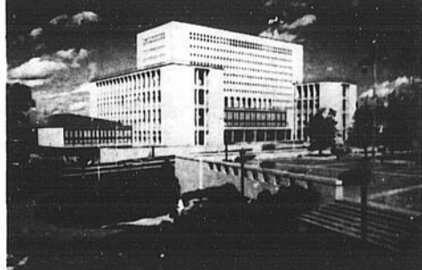
OTTAWA - Edifici della biblioteca e degli archivi pubblici
